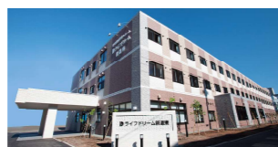
介護付有料老人ホーム 住宅型有料老人ホーム ライフドリーム新道東 札幌市東区北34条東21丁目1-7
